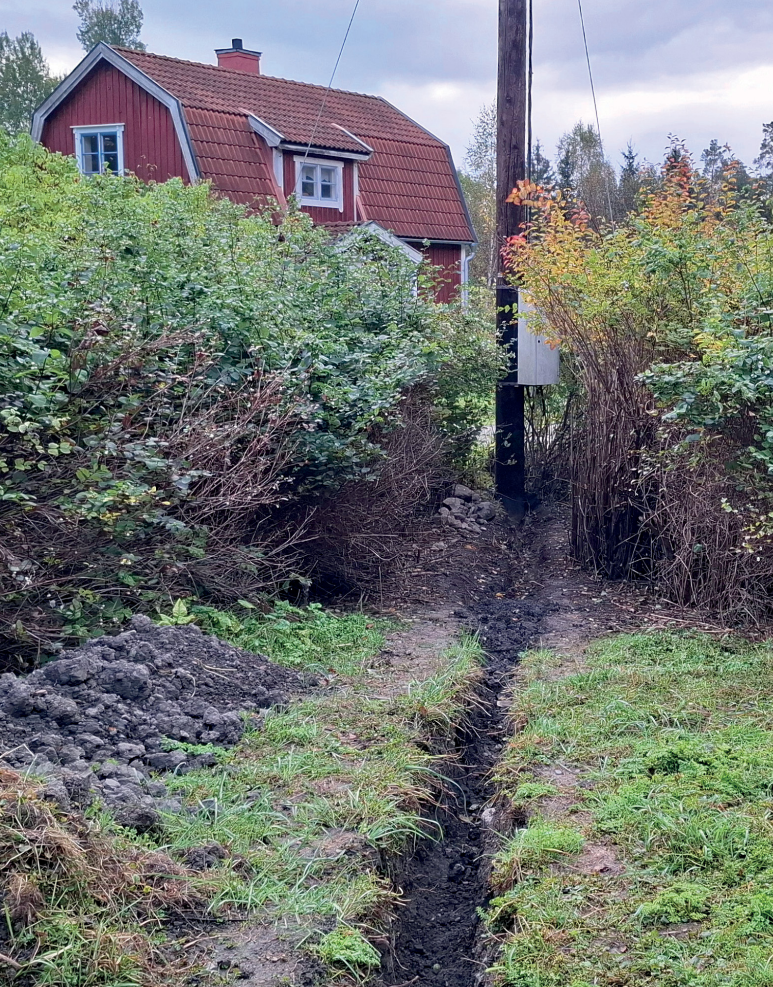
Figur 3. Del av det grävda schaktet (200) fotograferat från norr.
