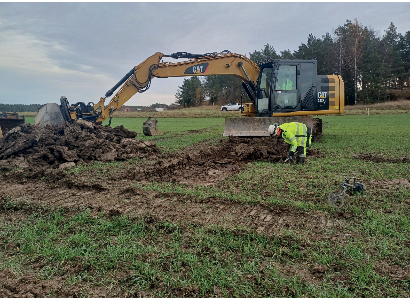
Figur 3. Sökschaktning och handrensning inom UO. Foto från nordväst.
