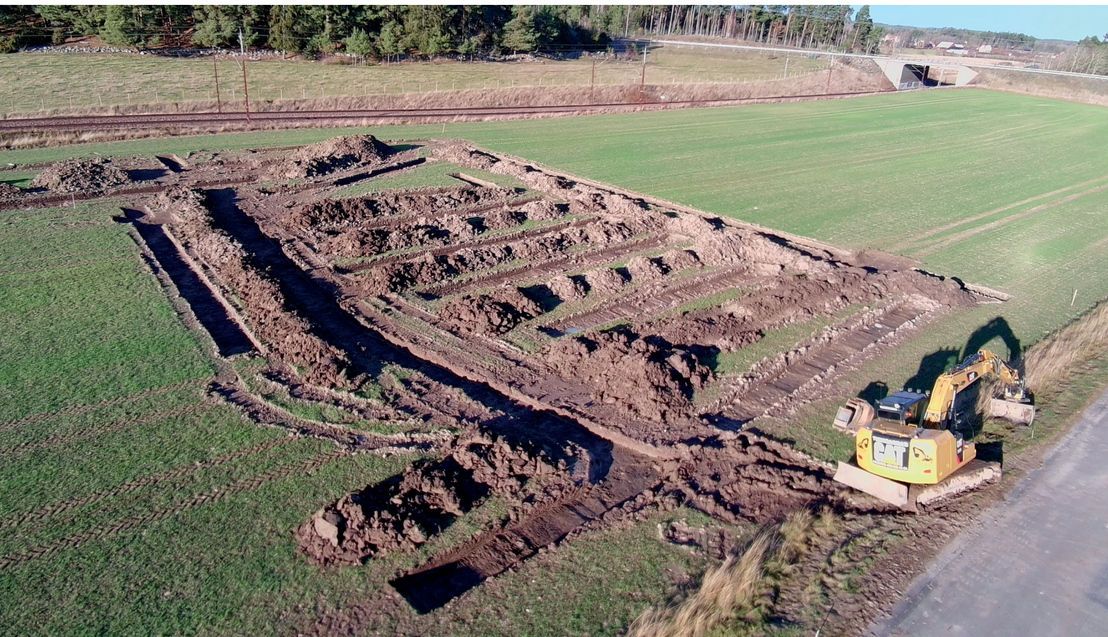
Figur 6. Sökschaktning inom UO. Foto från söder. Publicerad med Lantmäteriets spridningstillstånd LM2024/065589.
