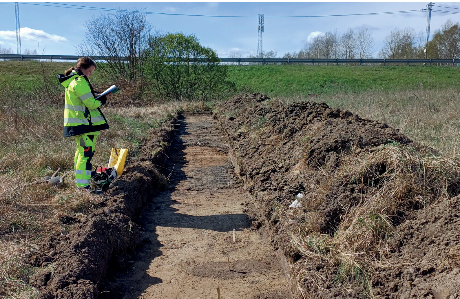
Figur 4. Dokumentation av sökschakt. Foto från öst.
