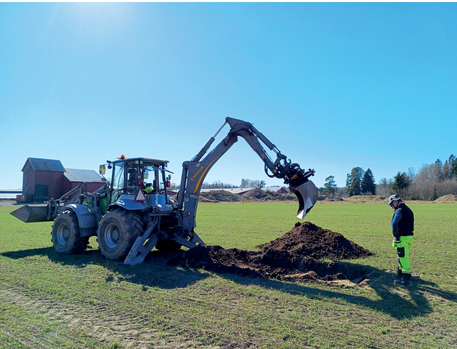
Figur 4. Sökschaktning med grävmaskin inom UO:s norra del. Foto från nordöst.
