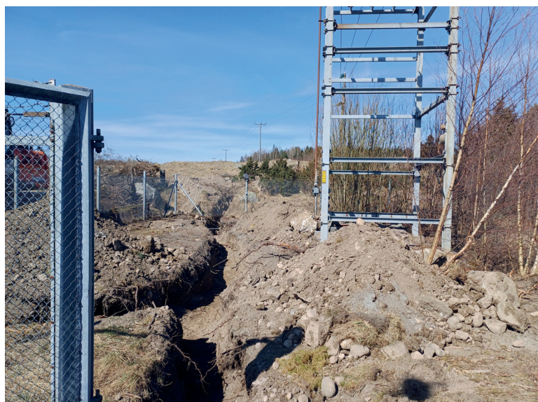
Figur 7. Schakt 300 inom den centrala ytan. Foto mot norr.
