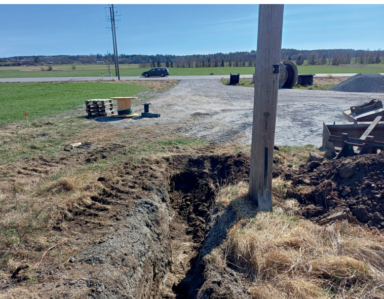
Figur 9. Den södra delen av schakt 300. Foto mot söder.
