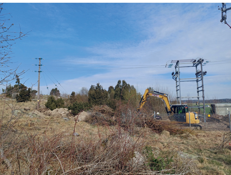
Figur 5. Schaktning inom den norra ytan. Foto mot öster.
