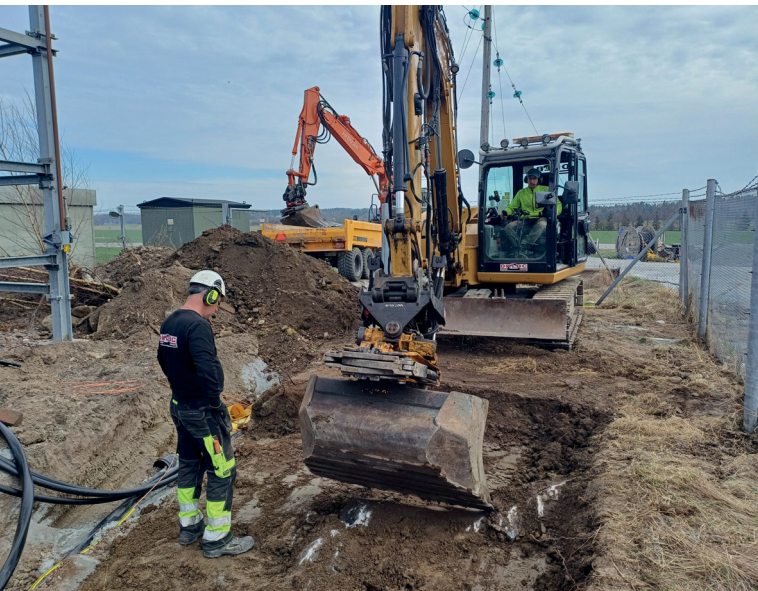
Figur 8. Grävning av schakt 291. Foto mot söder.
