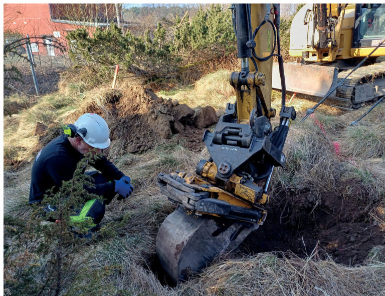
Figur 6. Grävning av schakt 210. Foto mot väst.
