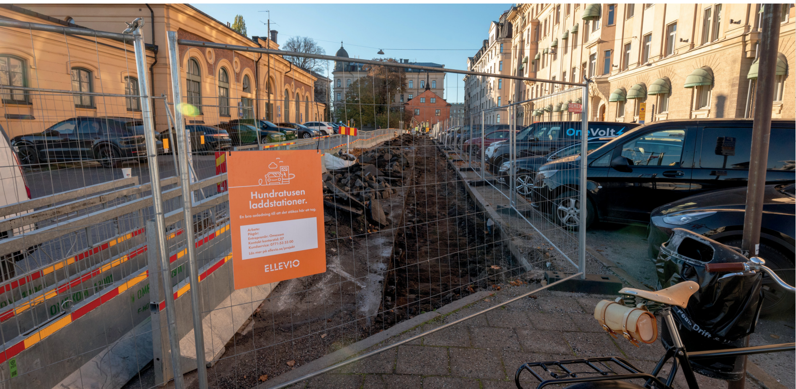
Figur 8. UO och påbörjad grävning av schakt 230. Foto från nord-nordöst.
