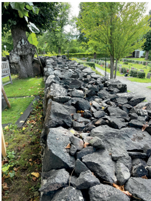
Figur 6. Den västra kyrkogårdsmuren fotograferad från norr, före omläggningen.
